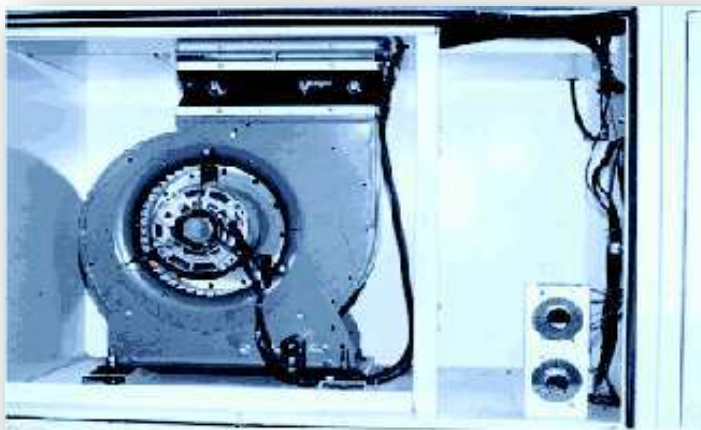
Figura 19. Ventilador centrífugo
