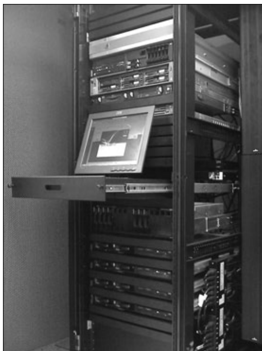
Figura 10. La consola IP se conecta a todos los equipos en el centro de cómputos. Está físicamente allí; nosotros accedemos por red y, así, a todos los equipos conectados a ella.
