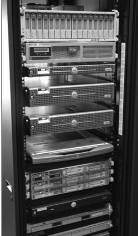
Figura 9. En cada ubicación podemos colocar un servidor, un switch, un router o cualquier otro dispositivo. Los servidores tienen correderas para facilitar el acceso.
