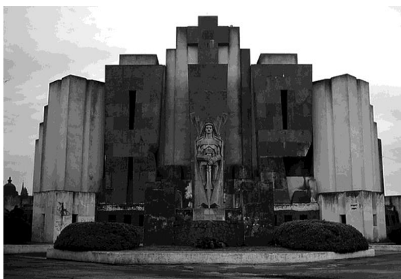
Construcción en hormigón. Arq. Francisco Salamone, Cementerio de Azul (fot. E. Lazzari)
