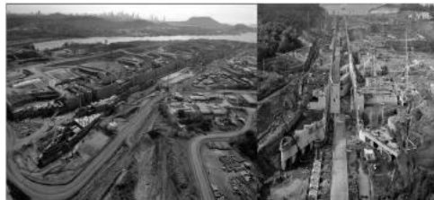
Fotografía 21. Construcción de la ampliación del Canal de Panamá.
